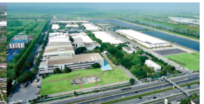
タイ バンパイン工場 | Bang Pa-in Plant, Thailand
